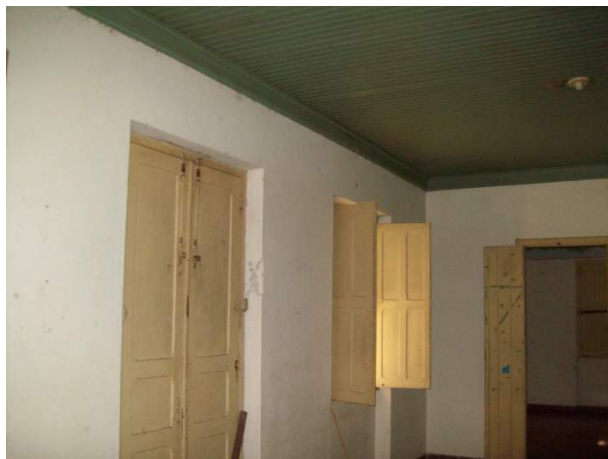
Figura 15 – Sala principal da casa, com forro e esquadrias em madeira
