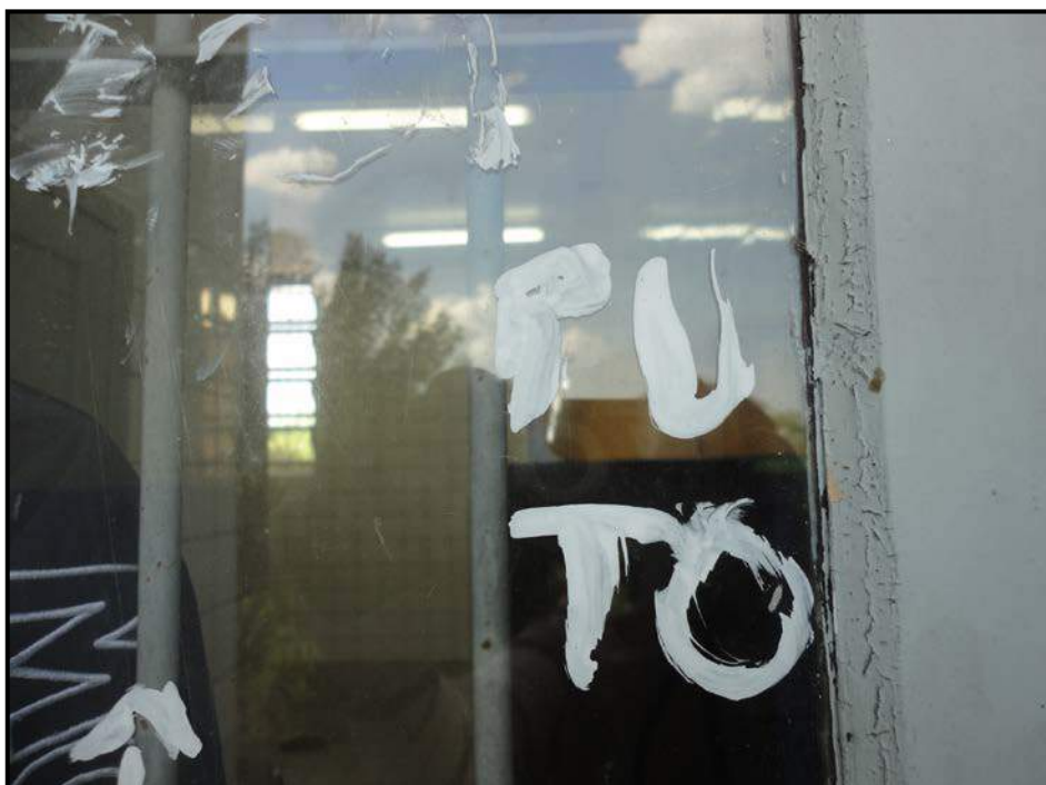
Figura 4 – Janela que dá acesso à cozinha no prédio central do Colégio Pasqualini
