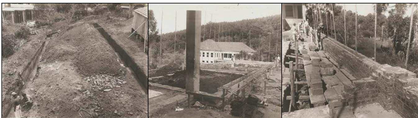
Figura 2 – Fase de construção da Escola Normal Católica, 1929 a 1931
