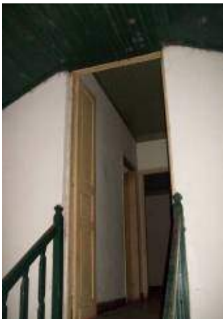
Figura 18 – Escada entre a cozinha e o pavimento principal. Detalhe do caimento do forro em madeira.
