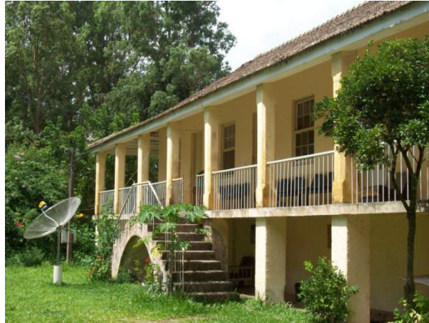
Figura 13 – Fachada frontal do casarão, com uma escada principal de um lanço para cada lado
