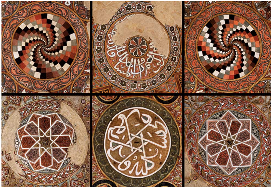
Figura5: Detalhe iconográfico de tetos semi restaurados. 2004
